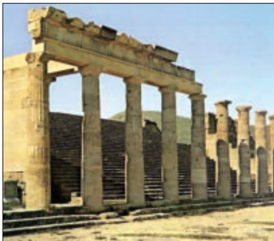
Μεγάλη στοά στην είσοδο της ακρόπολης της Λίνδου (αρχές του 2ου αι. π.Χ.). Η κατασκευή κοσμικού χαρακτήρα κτηρίων, όπως οι στοές, είναι χαρακτηριστικό της αρχιτεκτονικής των ελληνιστικών χρόνων.
