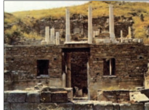
Οικία της Δήλων. Οι μεγαλύτερες οικίες είχαν εσωτερική αυλή (αίθριο), πολλά δωμάτια και δύο ορόφους.
