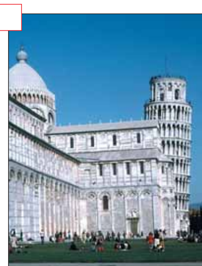
Πύργος της Πίζας
